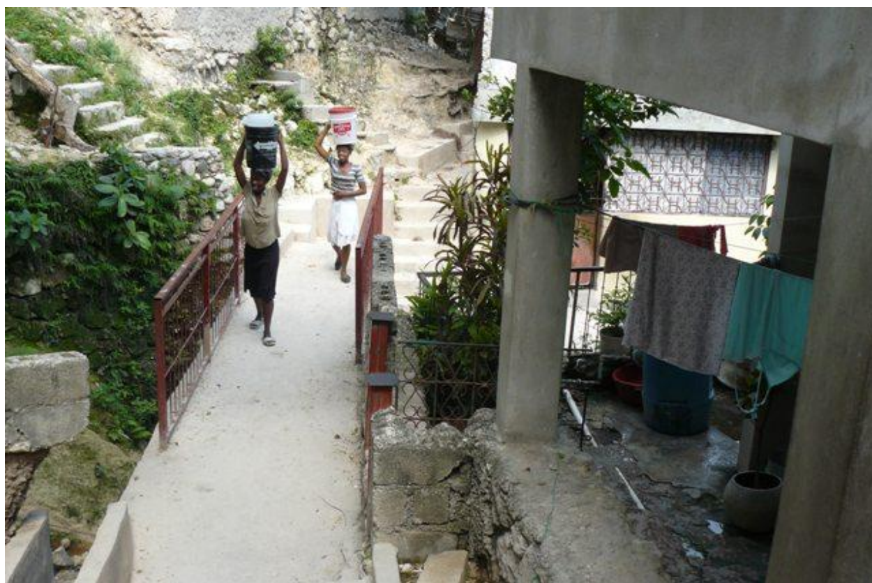
Pont de la ravine Takwèt 1 réhabilité par l'organisation SCJB, 2013
