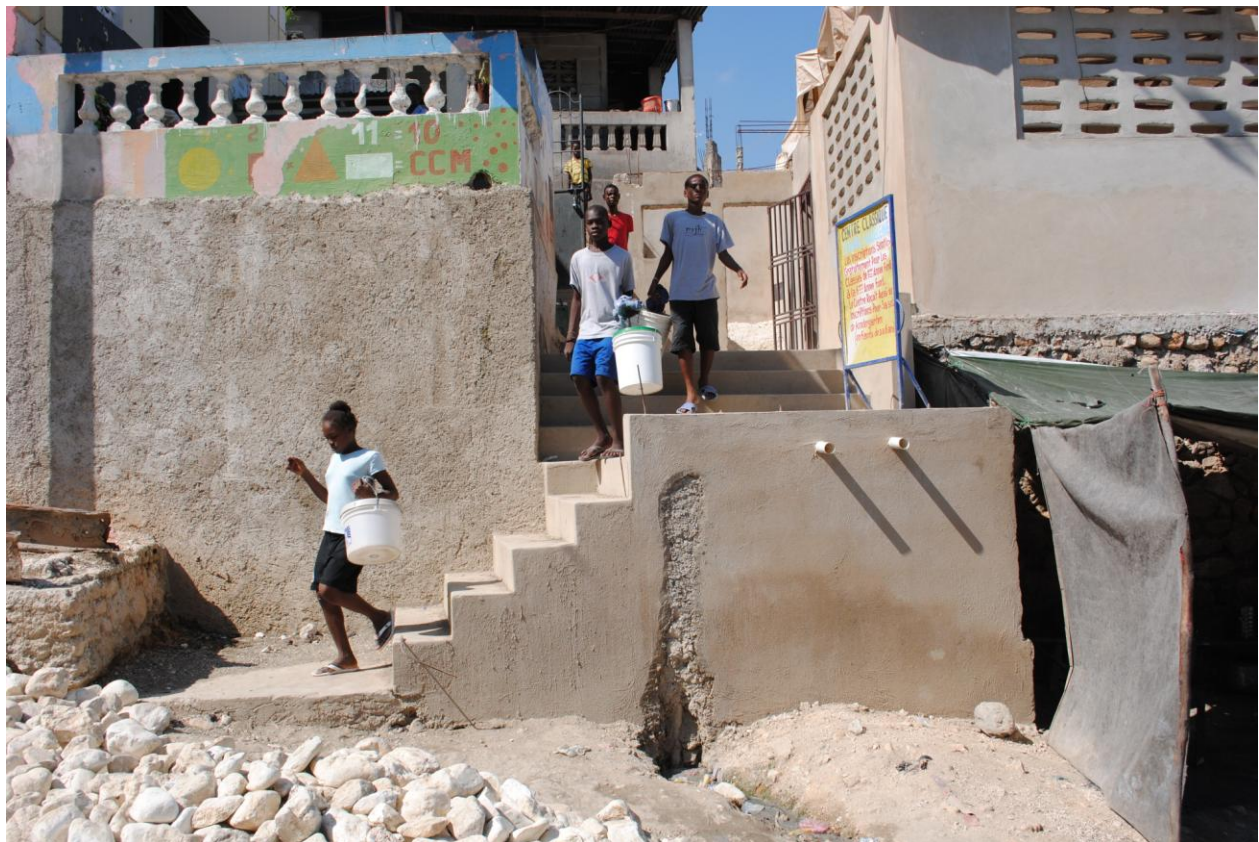
Réhabilitation d'un escalier à côté d'une école de Grand Ravine, Martissant, 2012
