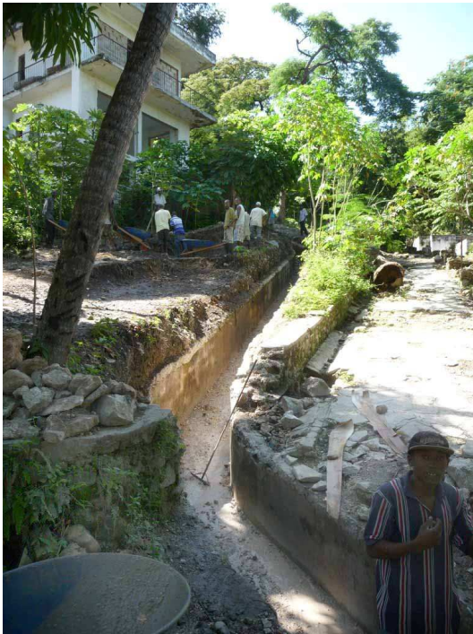
Les travaux de dégagement du canal Takwèt 2
