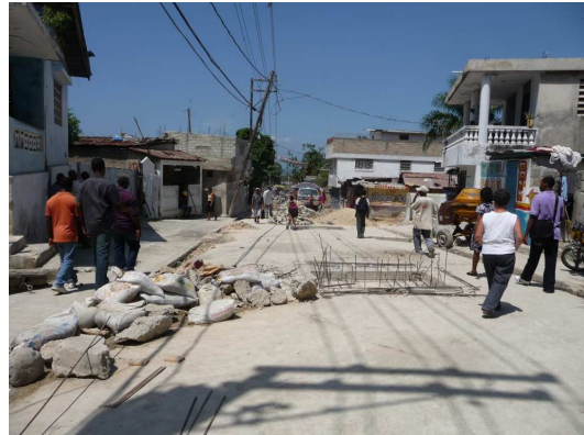
La rue Martissant 23 en cours de réhabilitation (septembre 2009)
