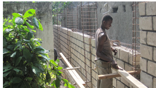
Travaux de clôture, partie nord de l'habitation Leclerc, avril 2010
