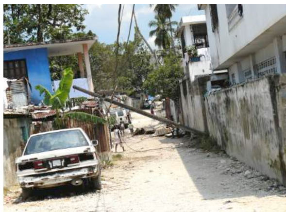
Poteau EDH couché, quartier de Manigat, 2008
