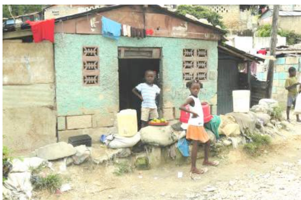
Quartier de Soray, petite digue construite devant l'entrée de la maison pour limiter les inondations
