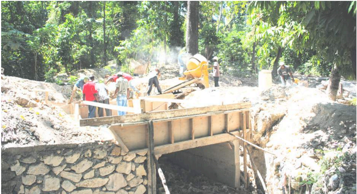
Travaux de canalisation d'une ravine dans le parc de Martissant, 2011
