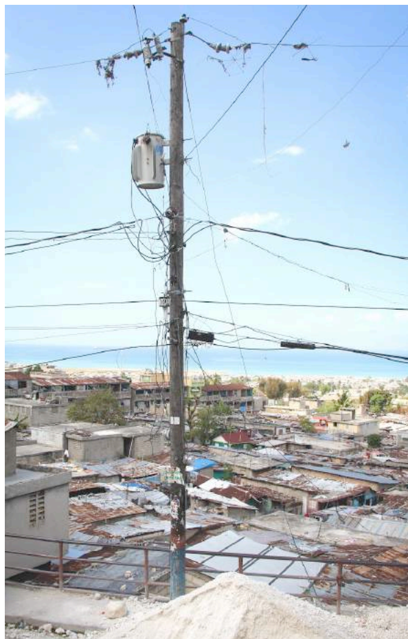
Poteau électrique sur la route des dalles
